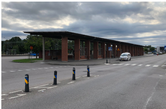
Bussterminalen och bangårdsgatan, sedd från nordöst i augusti 2020.
